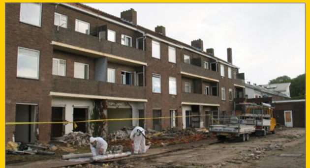
Asbestvrij maken voor totaalsloop.
